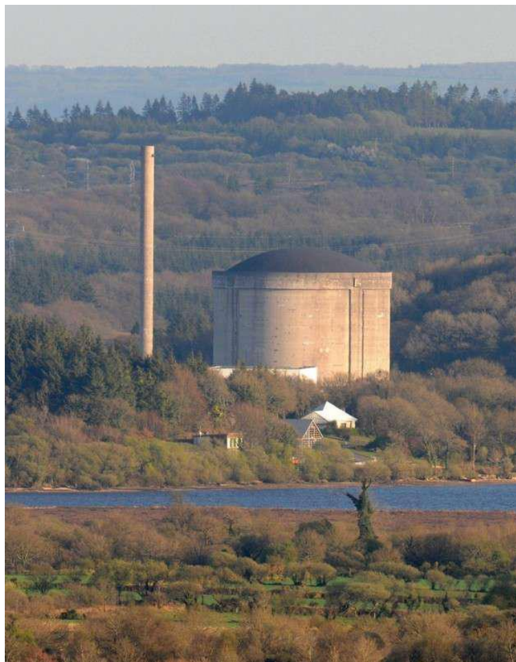
Centrale Nucléaire de Brennilis
